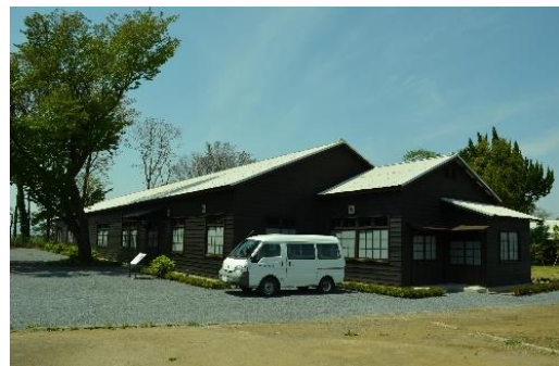
兵舎・下士官室・医務室棟
